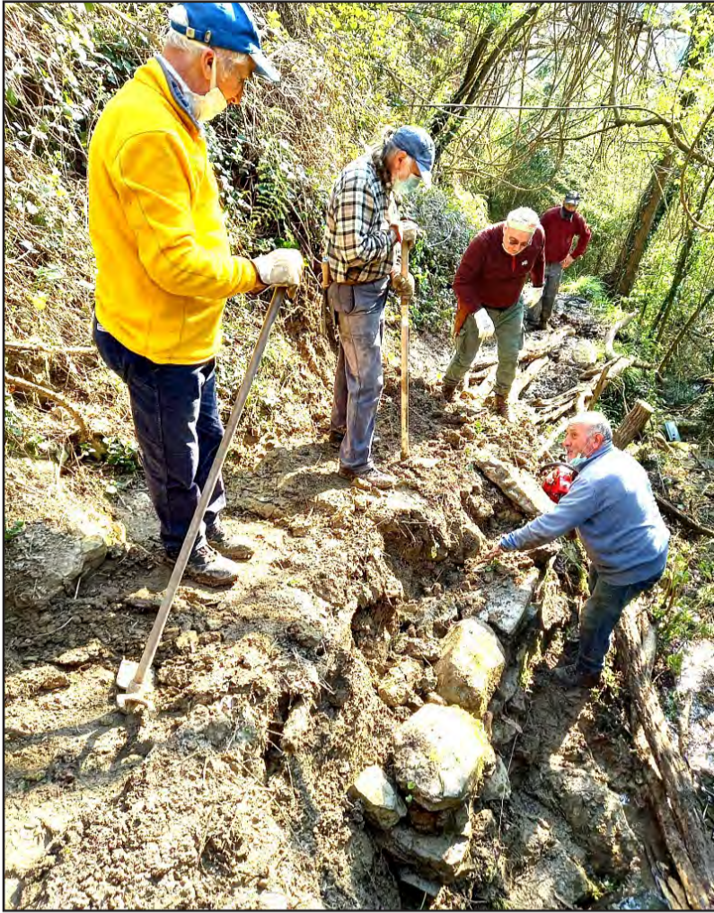
L a squadra "genieri" del CAI di Sarzana all'opera nella ricostruzione di un tratto franato del sentiero 309 Castelnuovo/cascata Traaton
