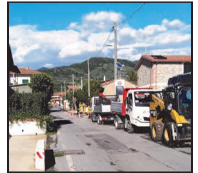
Il cantiere aperto in Via Provinciale
