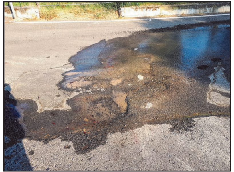
La perdita in via Borghetto, angolo "Residenza Oasi" da cui ha continuato a uscire acqua per più di un mese.
