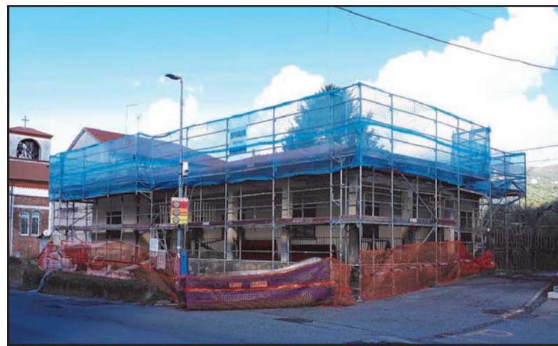
Il nuovo Centro per l'Autismo in via di ristrutturazione
