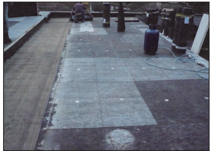
Una fase della lavorazione dell'impermeabilizzazione e coibentazione del tetto dell'Auditorium
